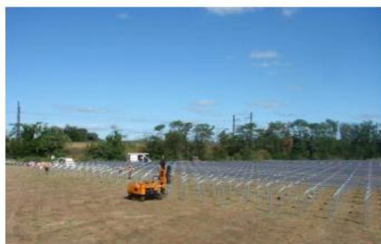
Battage des pieux
