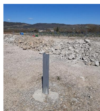
Figure 10- Exemple de pieux forés bétonnés
