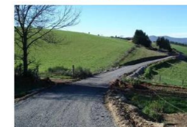
Mise en place du gravier
