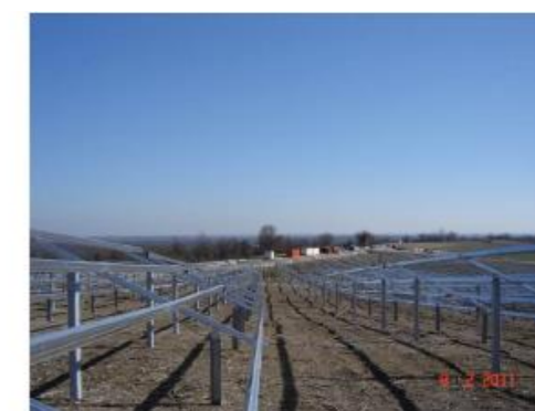
Fixation des rails de support
