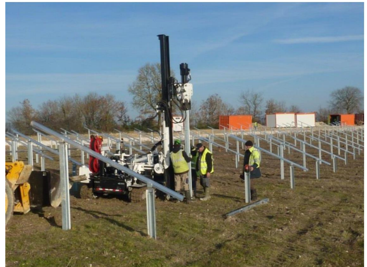
Figure 3 : Mise en place de support de panneaux
