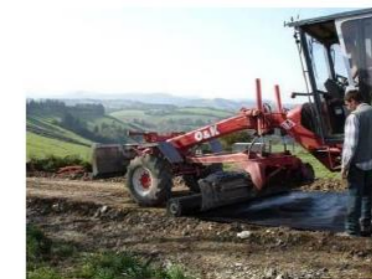
Pose du géotextile
