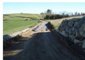
Mise en place du gravier
